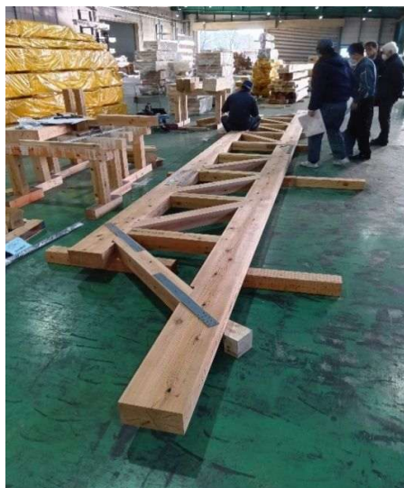
Fig2-2 トラス製作状況
