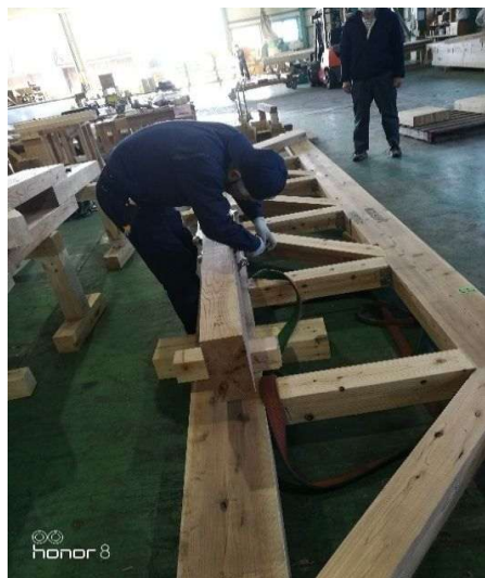
Fig1-2トラス製作状況
